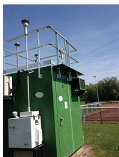
Station fixe de Nogent sur Oise
